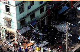
凌晨02:35 温州一住宅区突发爆炸 300米范围内房炸得面目全非，1人重伤，4人轻伤，2辆轿车被烧毁
