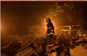
6·11苏州燃气爆炸 江苏一家燃气公司生活区办公楼食堂发生爆炸，约400m³三层办公楼坍塌，被埋的20人，死亡11人。
